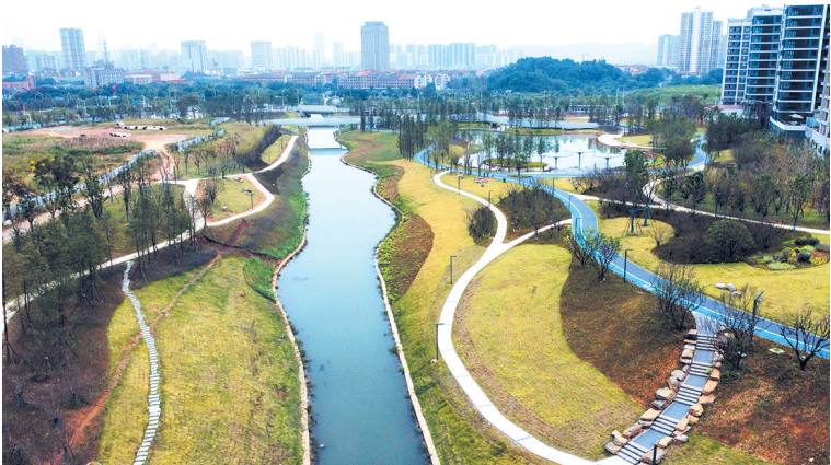
雷锋河生态公园项目（一期）日前竣工，融合生态、文化、运动、便民等多元功能。 长沙晚报通讯员 邓乐 供图
