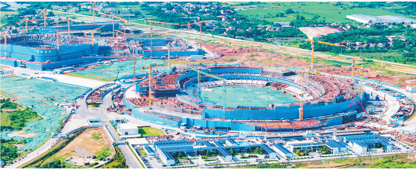
长沙奥体中心“一场两馆”正向着7月底主体结构全面封顶冲刺。 长沙晚报全媒体记者 邹麟 摄
