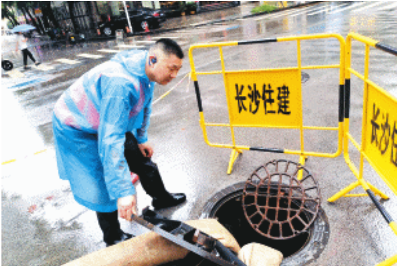
6月21日下午，长沙市城区防办工作人员在雨中进行排水作业。长沙晚报通讯员 陶海运供图
