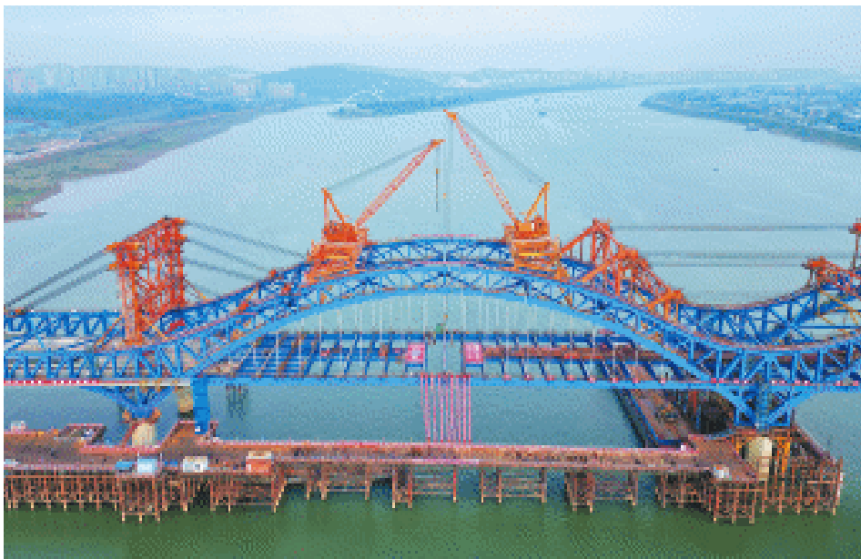
暮坪湘江特大桥项目具备“BIM+装配式+智能生产+智能施工+智慧运维”技术体系,通过数字技术赋能,实现工程建设的降本增效。长沙晚报全媒体记者 易亿 摄
